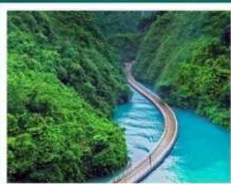
อัศจรรย์สะพานลอยน้ำ
