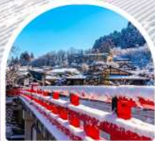
สะพานนากะบาชิ
